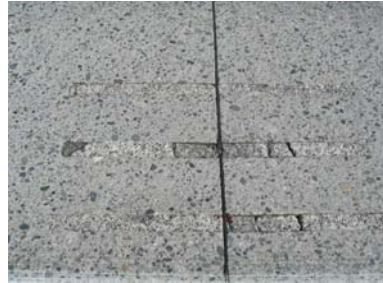
a. Cracking
